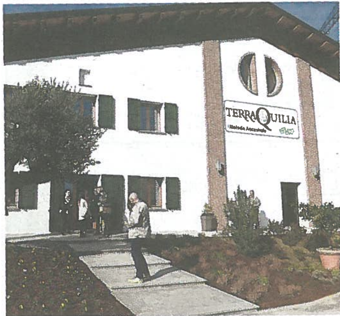
La nuova sede di Terraquilia, realizzata in appena sei mesi
